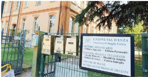
La sede dei servizi sociali dell'Unione Val d'Enza a Barco di Bibbiano
